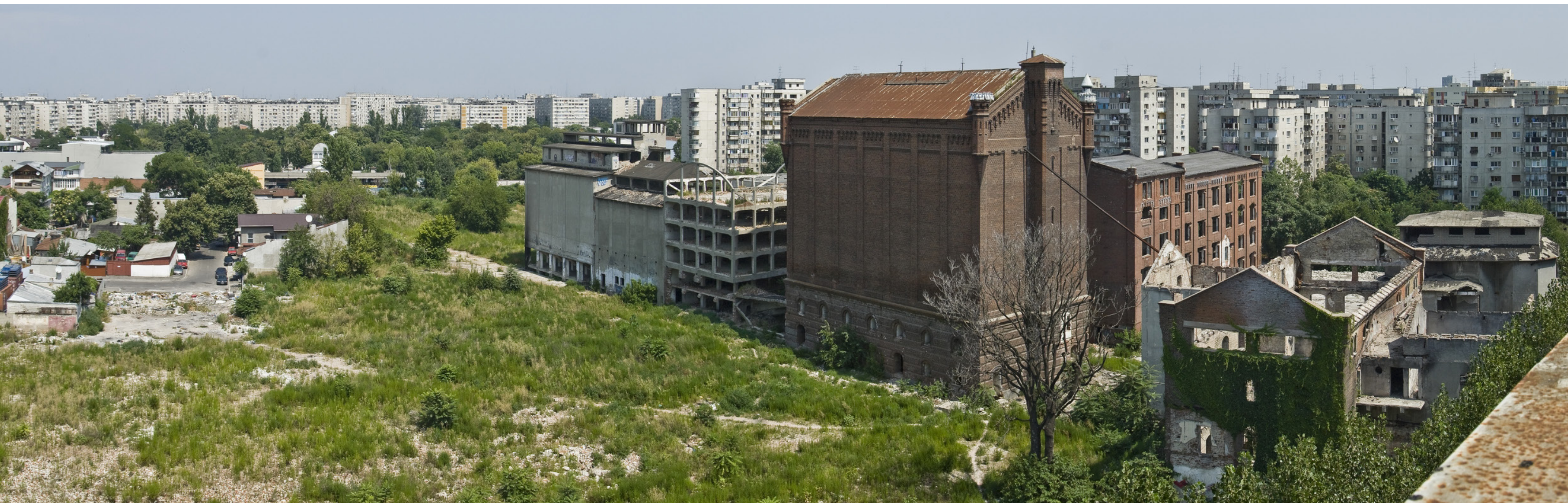
Vedere de ansamblu a complexului, interiorul și acoperișul clădirii din dreapta morii se vor prăbuși la sfârșitul lui 2011 (foto august 2010).
